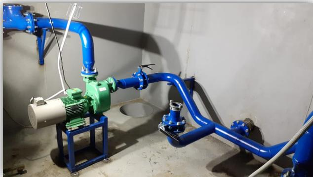
Монтаж оборудования насосной станции забора речной воды для производственных нужд цеха ЖБИ, г. Котлас, Архангельская обл.
