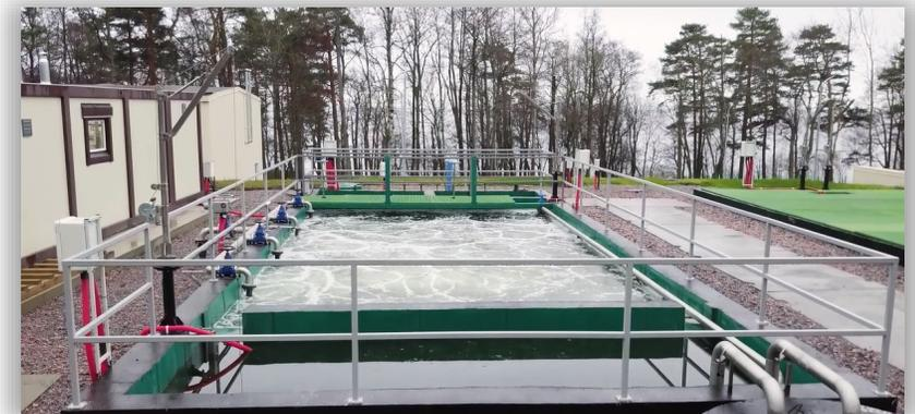
Монтаж оборудования аэротенка на базе трубчатых аэраторов с регулируемой подачей воздуха, КОС пос. Приветнинское, Ленинградская обл.
