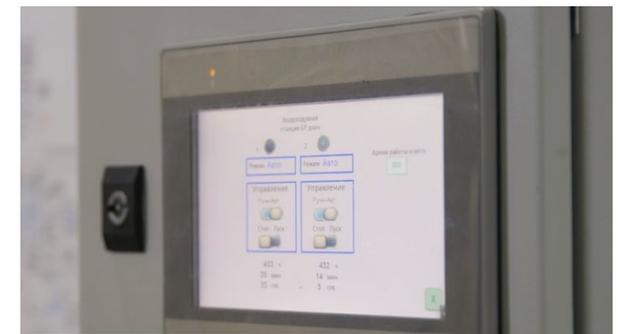
Автоматизированная система управления процессом очистки хоз-бытового стока на КОС поселка Приветнинское Ленинградская область.
